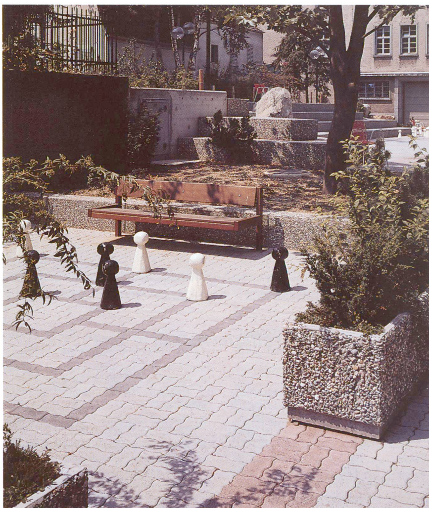
Verbundpflastersteine auf Spielplatz.
