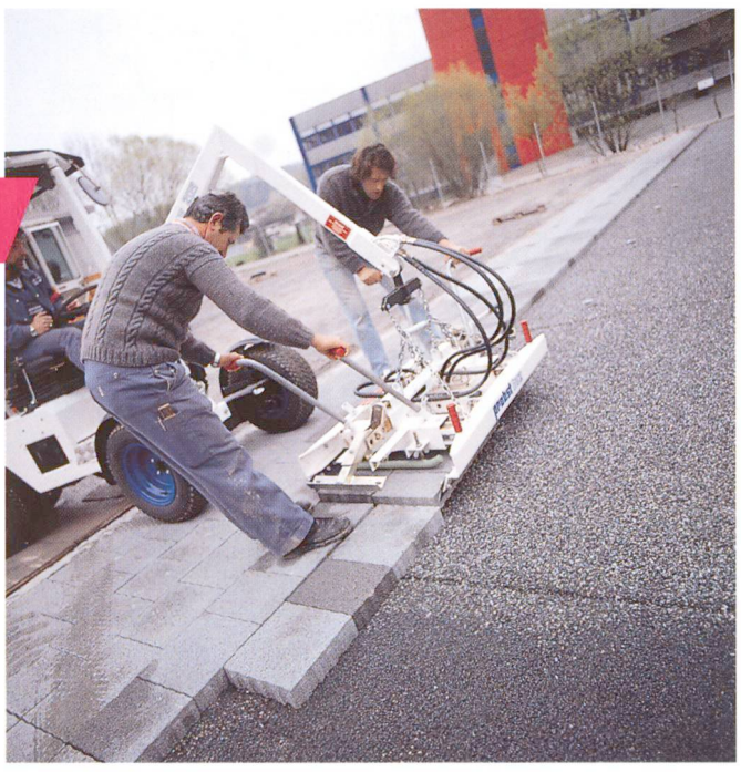
Verlegen von Betonpflastersteinen mit einer Verlegemaschine. Foto: FOTarena, Bern
