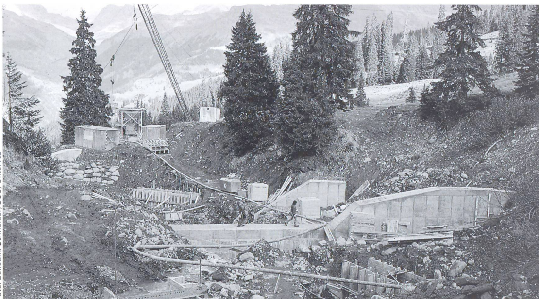
Bachverbauung: Pumpbeton- förderung in un- wegsamem Gelände.
