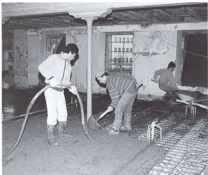
Altbausanierung mittels Holz-Beton-Verbundsystem (Leichtbeton LB 20/10, Rohdichte 1,5 kg/m 3 ).
