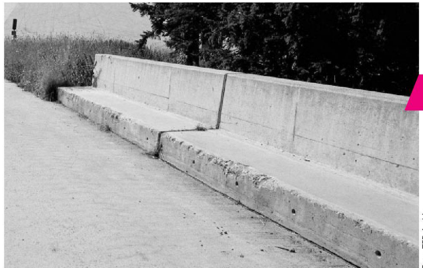
Frosttausalzschäden (Abplatzungen) auf Brückenbrüstung.
