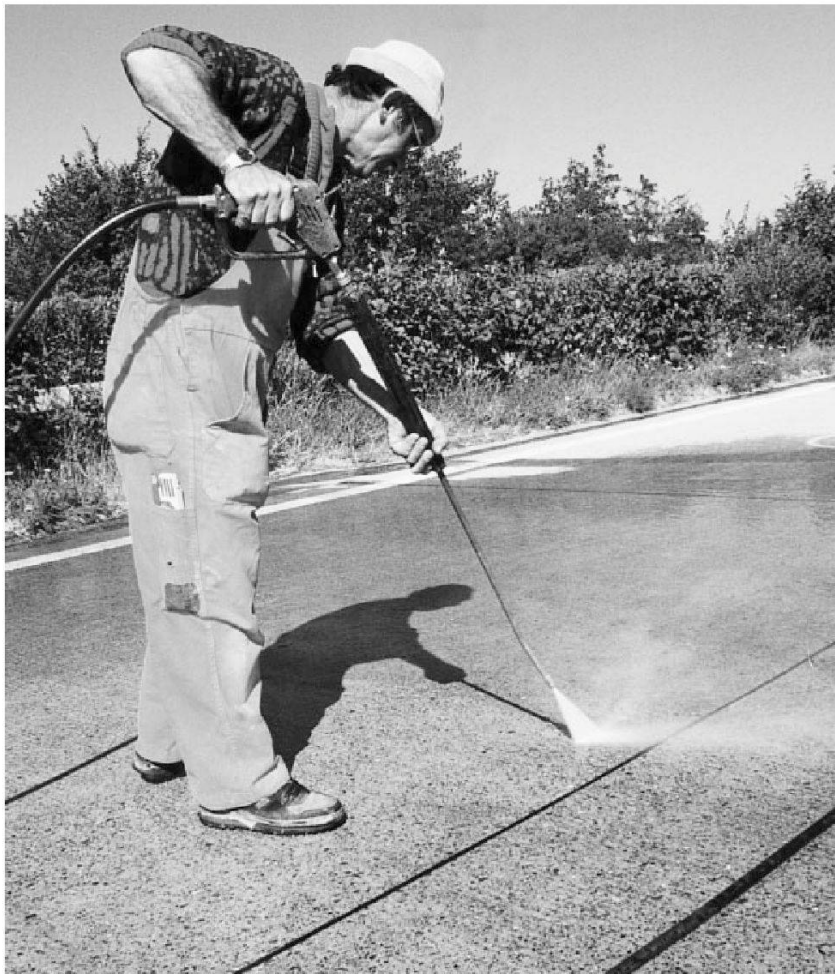
Reinigung einer Testfläche für die Hydrophobierung einer rund 16 Jahre alten Betonstrasse mit Hochdruckwasser (200 bar).
