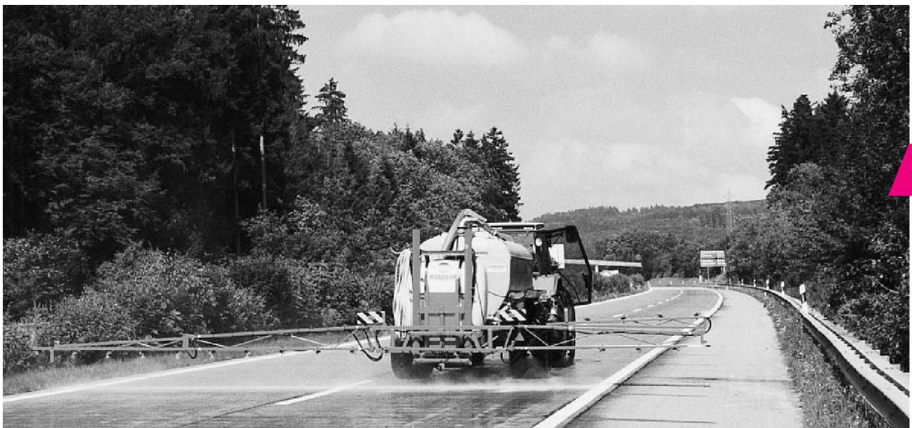
Hydrophobierung einer Betonfahrbahn.
