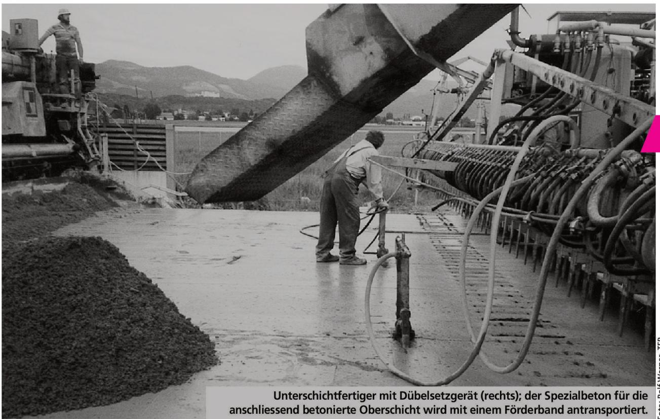
Unterschichtfertiger mit Dübelsetzgerät (rechts); der Spezialbeton für die anschliessend betonierte Oberschicht wird mit einem Förderband antransportiert.
