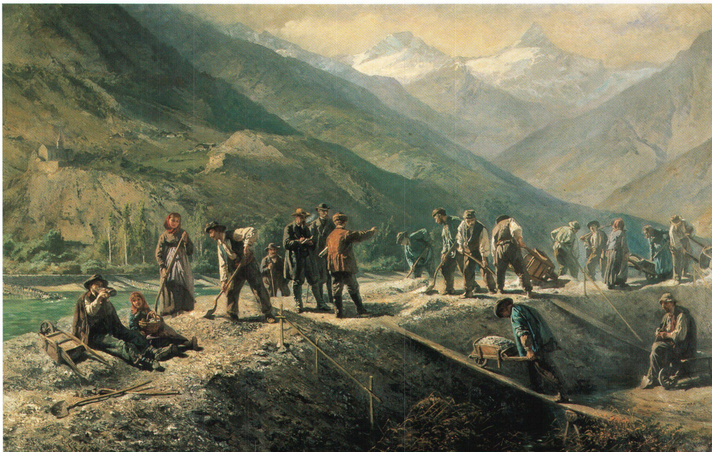
Abb. 3: Darstellung der Bauarbeiten am Linthkanal (Archiv «Linth-Escher-Gesellschaft»).
