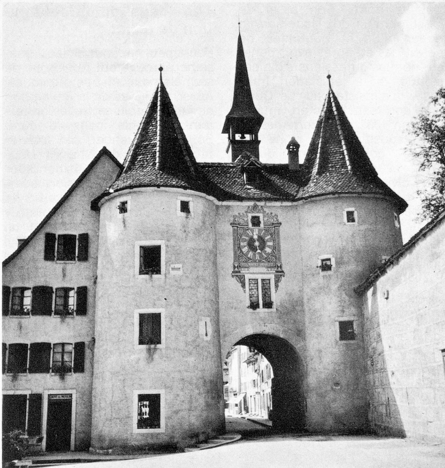
Porrentruy, la Porte de France
