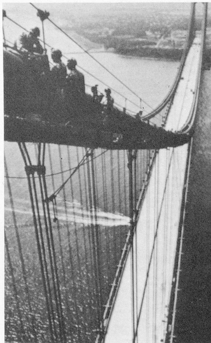
Réalisation de visions techniques audacieuses et couronnement d'une existence qui rompit avec les dimensions suisses : le Verrazano-Narrows Bridge en construction à New York. Inauguré peu avant la mort d'Othmar Hermann Ammann (1879-1965) il compte au nombre de ses plus beaux projets.
