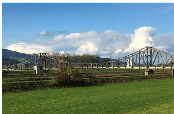
Alte Rheinbrücke Diepoldsau
