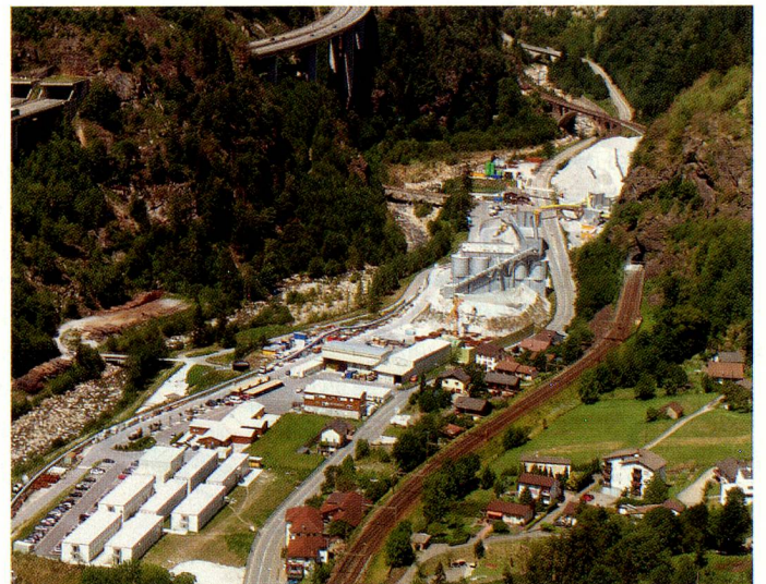
Grandes obras a la entrada del túnel de Faido.
