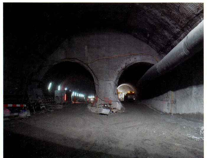
Con sus 57 km, el nuevo túnel de base es el túnel ferroviario más largo del mundo.
