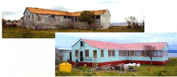
Edificio administrativo antes y después de la restauración
