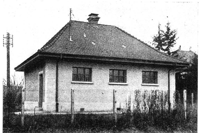
Fig. 32. Sous-centrale de Riehen, le bâtiment.
