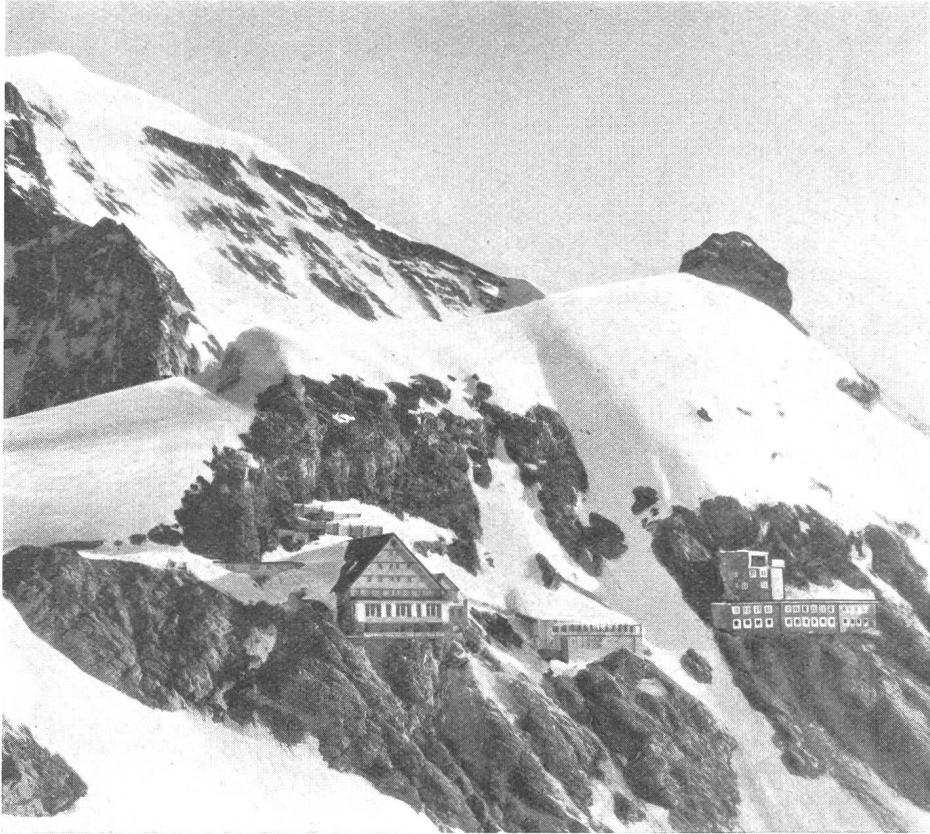
Fig. 1. Gebäude auf dem Jungfraujoch, dahinter der Mönch.
