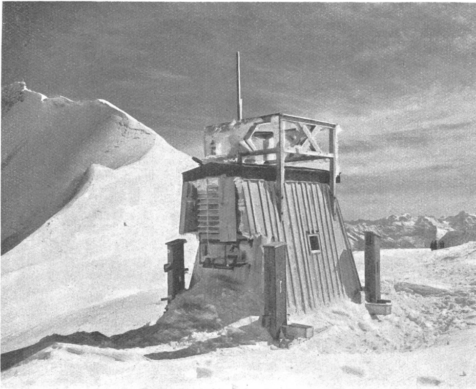
Fig. 2. Meteorologischer Holzpavillon nach de Quervain.
