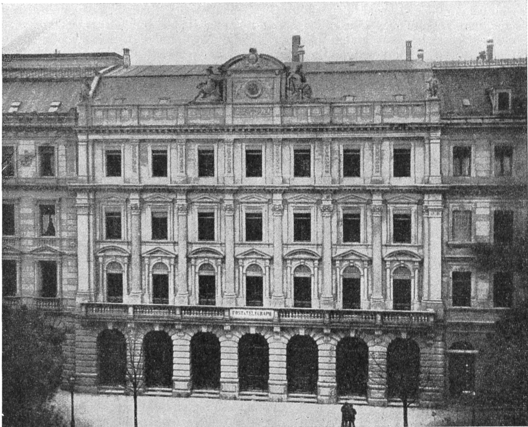
Abb. 7. Postgebäude Zürich 1873—1898 (Bahnhofstrasse 25). Jetzt Teil der Schweizerischen Kreditanstalt. Bild vom Postmuseum freundlich zur Verfügung gestellt.
