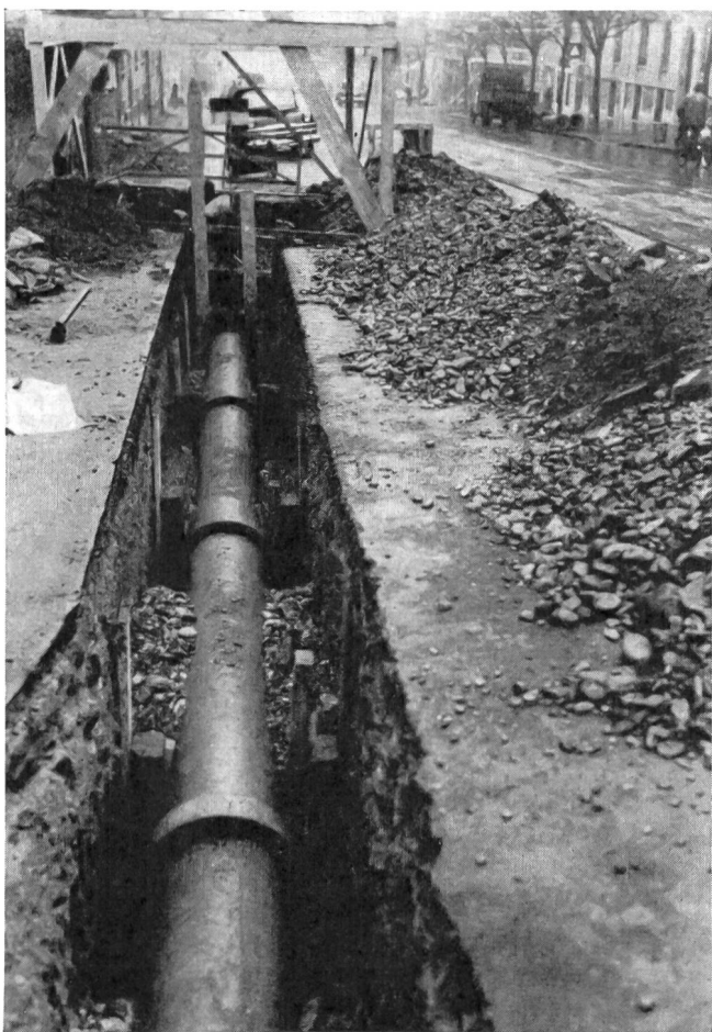
Fig. 3. Armierte Schleuderbetonrohre, fertig verlegt und verkeilt Tuyaux en béton armé centrifugé jointoyés et calés
