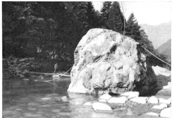
Fig. 8. Auslegung des provisorischen Kabels über die Reuss Pose du câble provisoire à travers la Reuss
