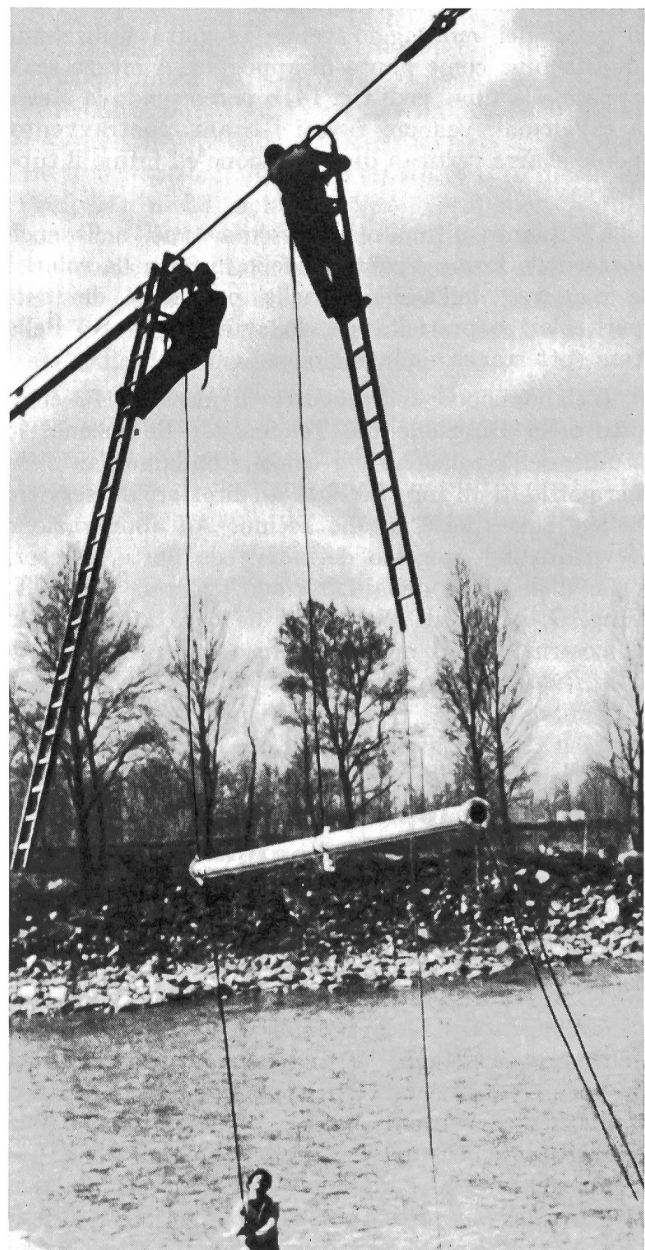
Fig. 14. Esecuzione del montaggio Ausführung der Montagearbeiten
