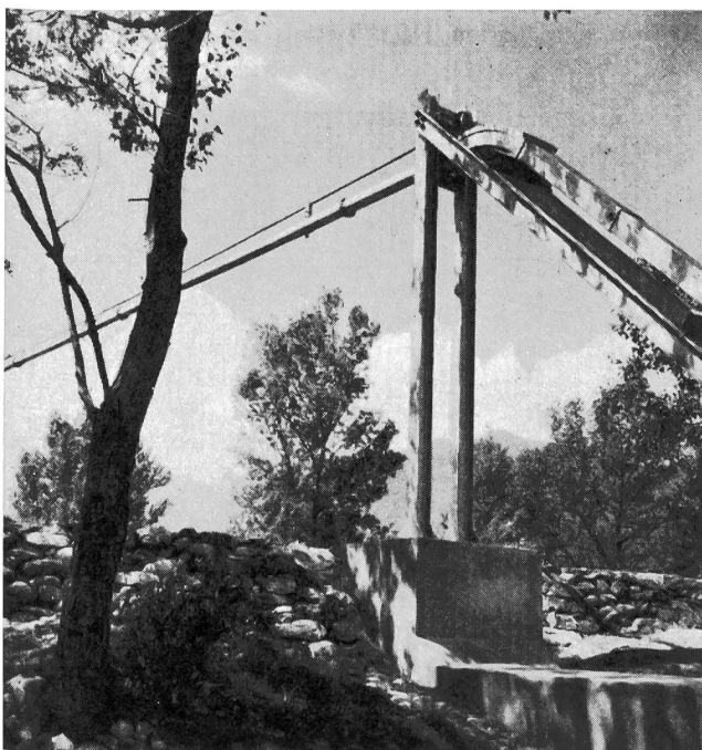
Fig. 3. Sostegno B, veduta generale Stützpunkt B, Gesamtansicht
