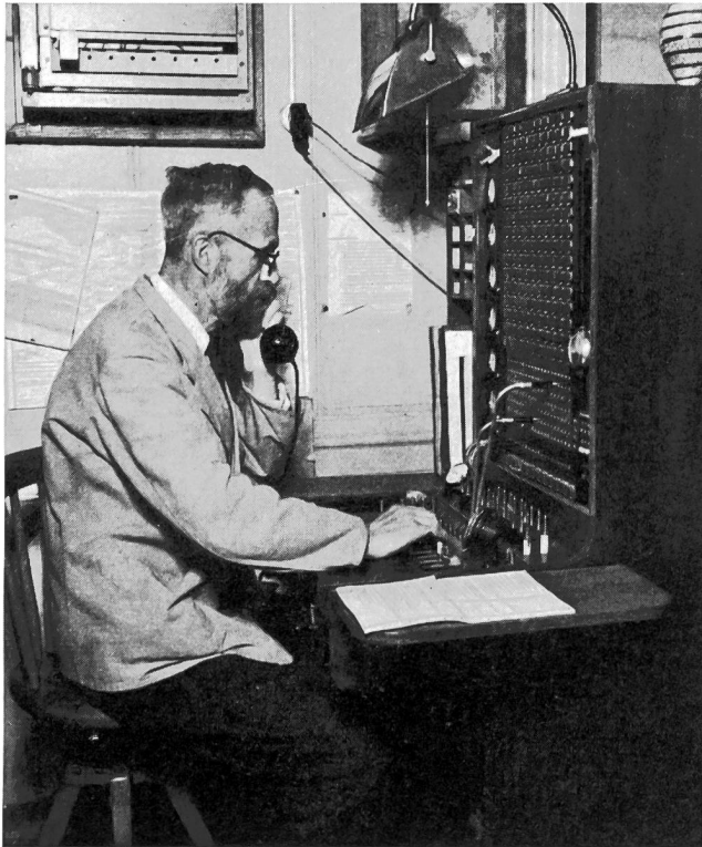
Fig. 7. Die bis zur Automatisierung in Betrieb gestandene handbediente Zentrale Poschiamo
