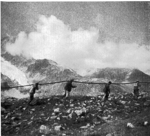
Fig. 5. Kabelauszug über eine Geröllhalde
