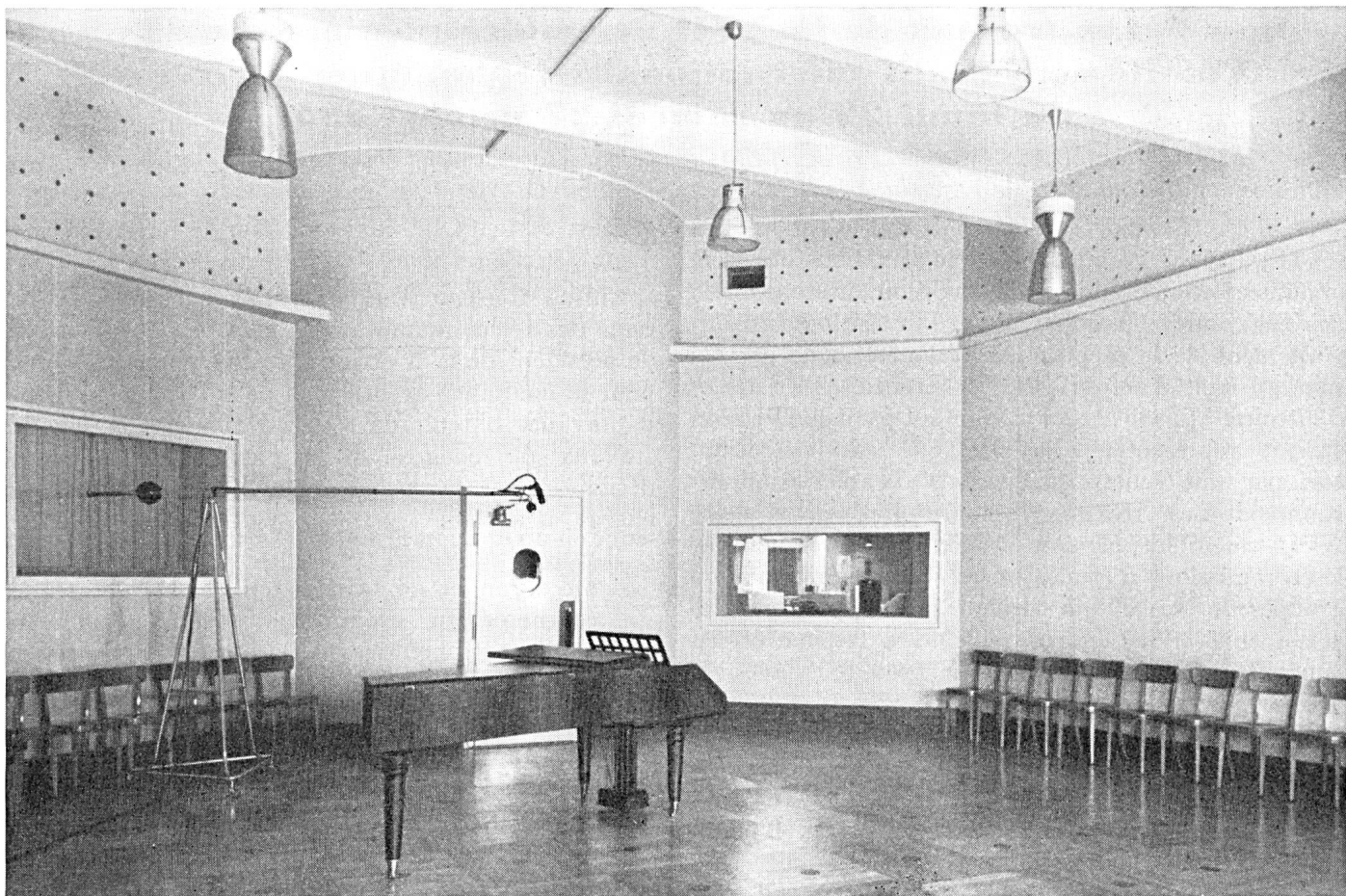
Fig. 5. Radiostudio in Zürich mit Helmholtzresonatoren aus Hohlkammersteinen Studio de radio à Zurich pourvu de résonateurs de Helmholtz en briques creuses
