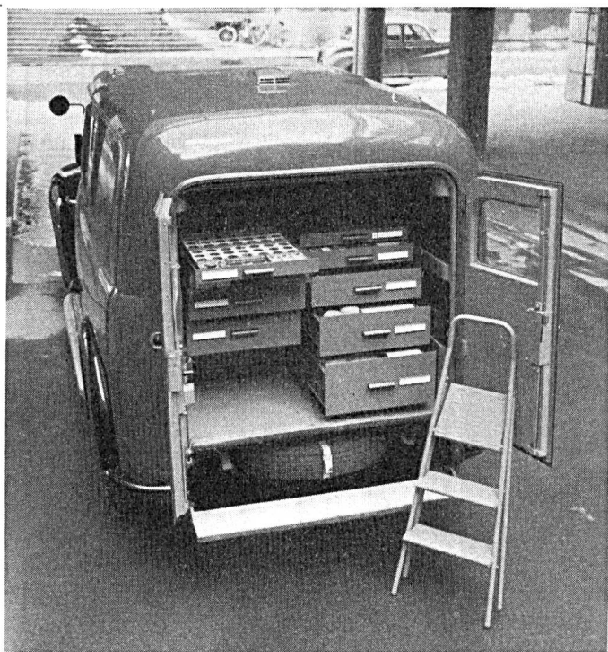
Fig. 4. Ausrüstung eines Fahrzeuges für den Unterhaltsdienst Equiptement d'une voiture pour le service d'entretien
