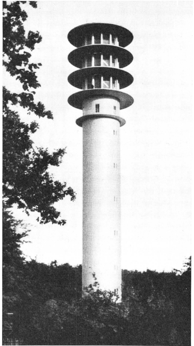
Fig. 12b. Fernmeldeturm Egestorf, 128 m ü. M., ein Stützpunkt der Richtstrahlverbindung Hamburg-Köln(-Frankfurt a. M.-Süddeutschland); dient auch gleichzeitig für mobile Dienste. Die tellerförmigen Plattformen sind zur Aufnahme der Richtstrahlantennen bestimmt. Turmhöhe 70 m. Die elegante Konstruktion passt sehr gut ins Landschaftsbild Das Bild wurde uns freundlicherweise vom Fernmelde-technischen Zentralamt in Darmstadt zur Verfügung gestellt
