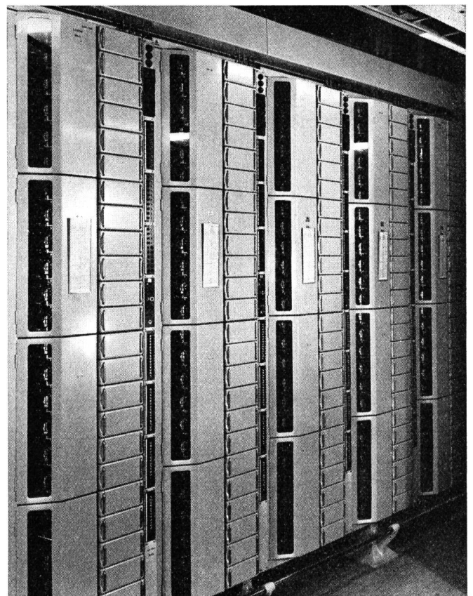
Fig. 4. Gestellreihe mit Gruppenwählerrahmen Rangée de bâtis avec cadre de sélecteurs de groupes
