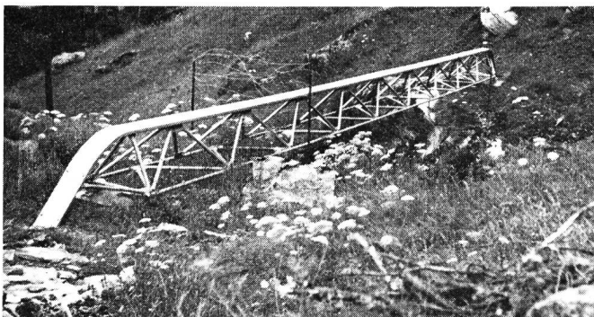
Fig. 2. Kabelbrücke in Rohrkonstruktion; Spannweite 14 m Support de câbles construit en tubes; portée 14 m
