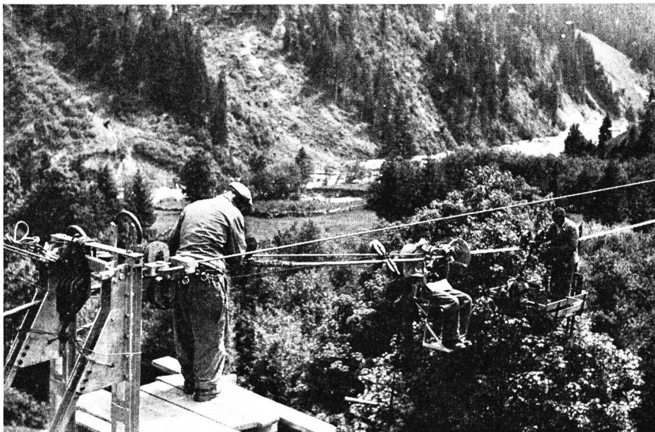
Fig. 10. Umwicklung von Kabel und Tragseil Fixation du câble au porteur
