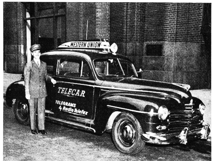
Fig. 6. Zustellautomobil mit Antenne und Faksimileapparat für den drahtlosen Empfang von Telegrammen vom Haupttelegraphenamt während der Fahrt
