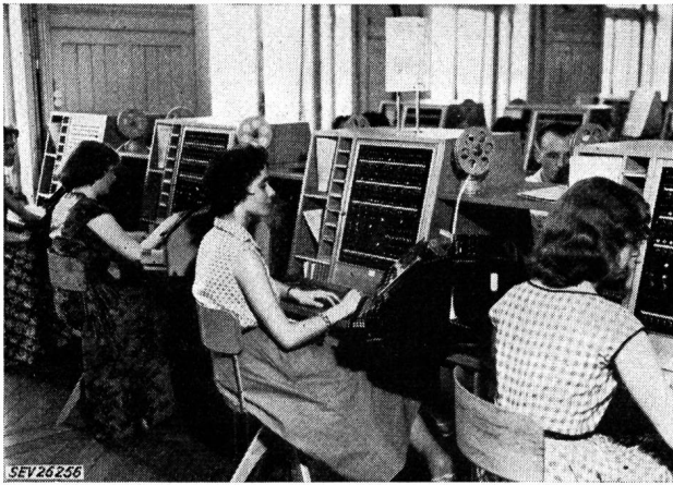
Fig. 8. Central manuel de Zurich, équipé entièrement de positions sans cordons
