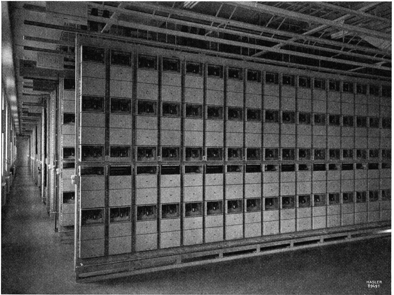
Fig. 1. Teilansicht des Tandemamtes Luzern (1951): Gestellreihe mit I. Tandem-Stromkreisen, Vierdraht
