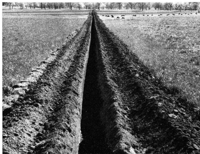
Fig. 10. Beispiel eines mit Kettenbagger ausgehobenen Grabens. Das Material ist getrennt gelagert Exemple d'une fouille creusée au moyen d'un excavateur à chaîne sans fin à godets. Le matériel est déposé séparément de chaque côté de la fouille
