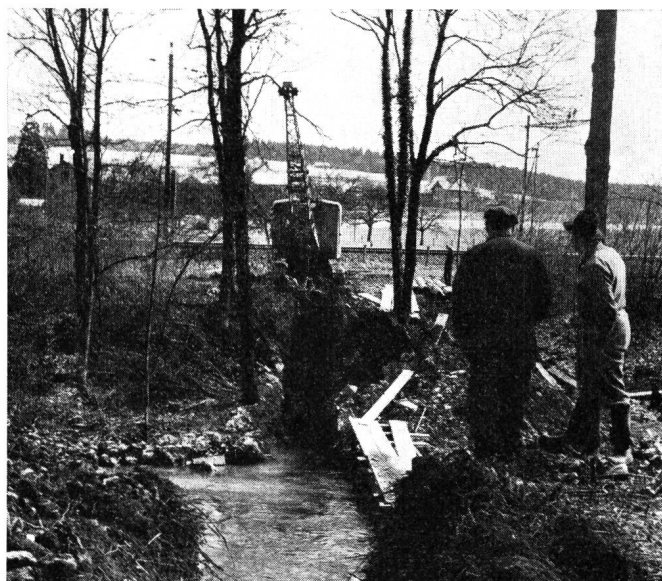
Fig. 8. Drag-Line im Einsatz an der Broye Dragline en action lors de la traversée souterraine de la Broye
