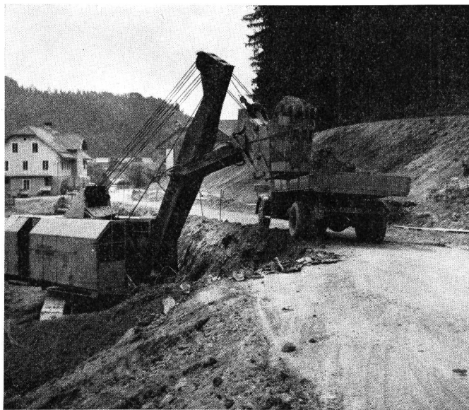
Fig. 1. Hochlöffelbagger beim Abtragen von standfestem Boden im Strassenbau Pelle mécanique équipée en butte en action dans une construction de route
