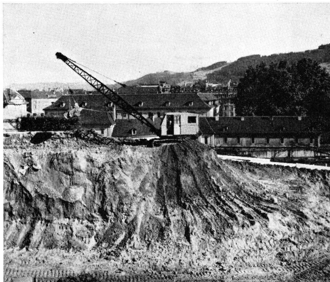
Fig. 9. Drag-Line mit grosser Reichweite beim Erdabtrag Dragline exécutant des travaux d'enlèvement de terre
