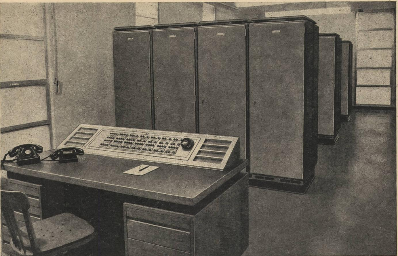
Für die neue Funkanlage der Stadtpolizei Zürich erstellten wir die Ausrüstung für die automatische und manuelle Vermittlung der Funkge-
