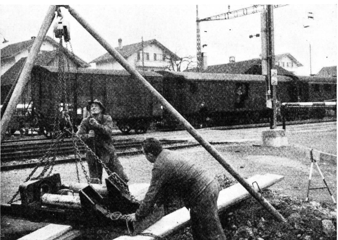
Röhren-Stosswinde für 3- bis 6-Zoll-Stahlrohre an einem Dreibein aufgehängt Pousse-tubes pour tuyaux de 3 à 6'' suspendu à une chèvre
