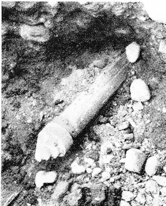
Strasse unterstossen, Pilot sichtbar Traversée sous une route, pilote visible
