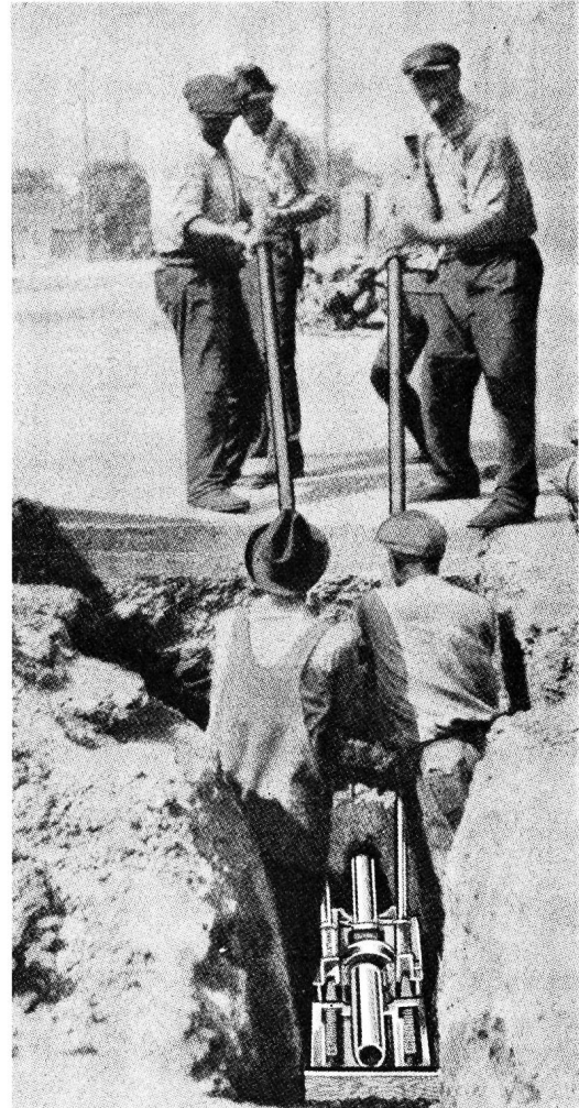
Röhren-Stosswinde eingesetzt. Betätigung von der Grabensohle und vom Grabenrand aus
