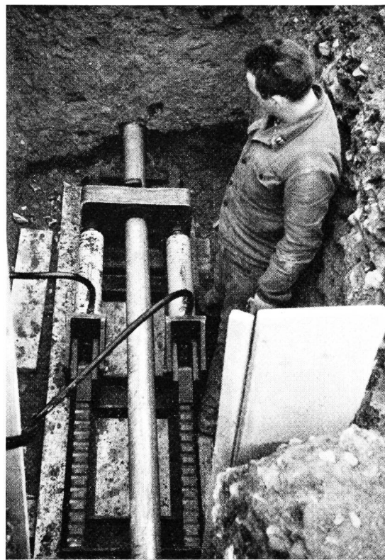
Röhren-Stosswinde für 3- bis 6-Zoll-Rohre in Aktion Pousse-tubes pour tuyaux de 3 à 6" en action
