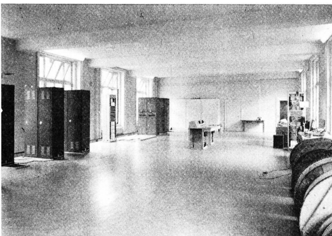
Fig. 4. Beginn der Montage des neuen Übersee-Terminalamtes Bern
