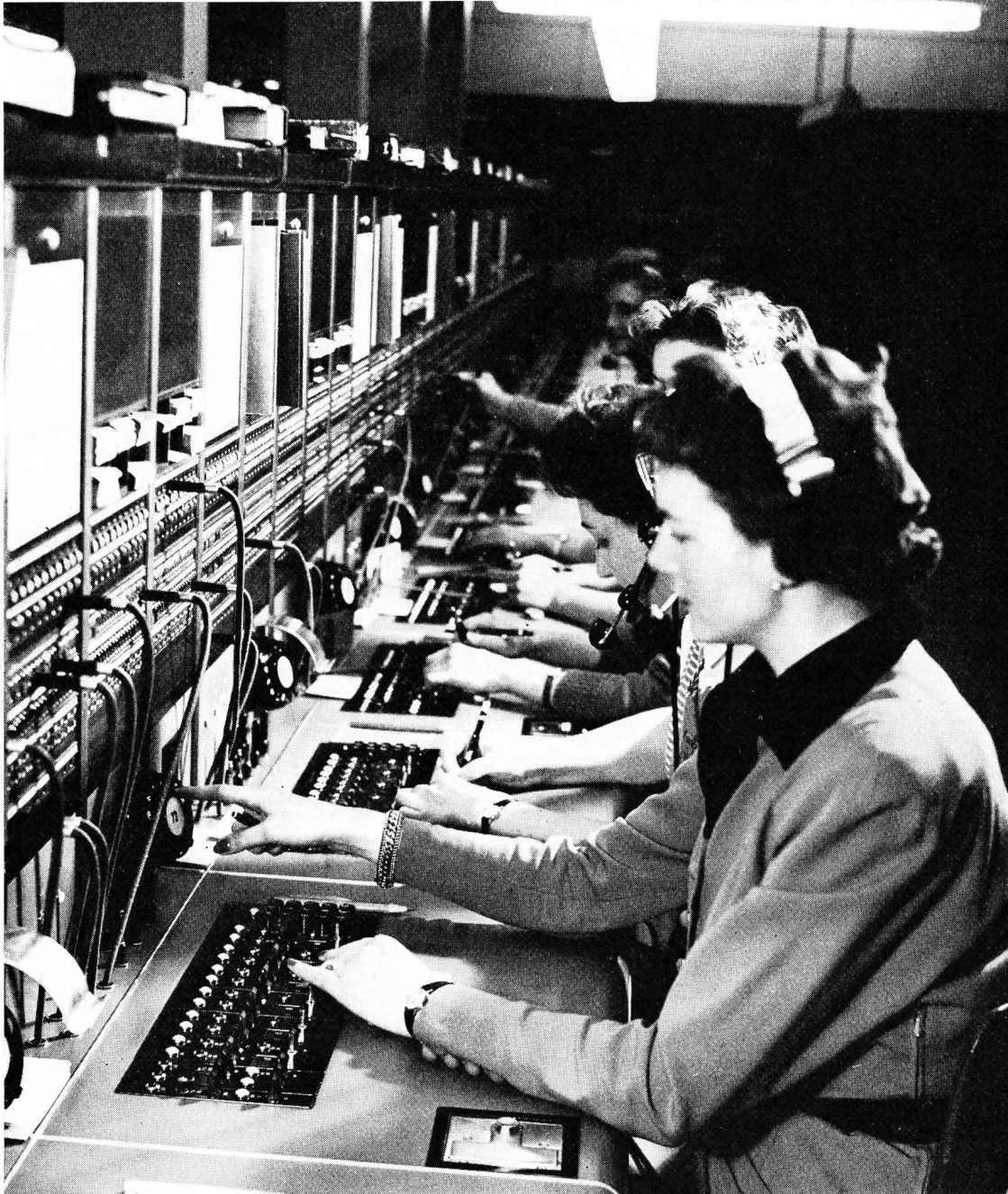
Fig. 7. Moderne manuelle Vermittlungszentrale für den internationalen Telefonverkehr
