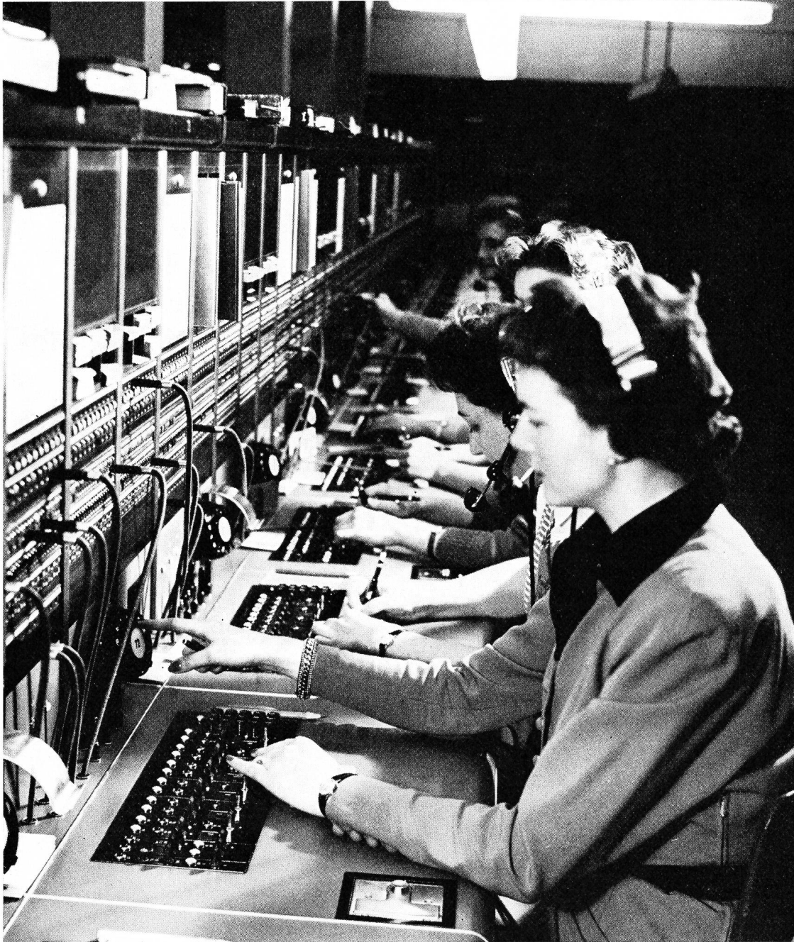
Fig. 7. Moderne manuelle Vermittlungszentrale für den internationalen Telefonverkehr
