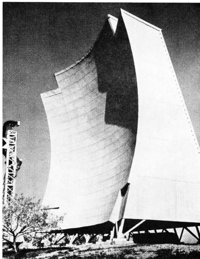
Fig. 22. Antennenanlage für Streustrahlverbindungen. Um eine möglichst starke Bündelung der Wellen zu erreichen, werden Antennengebilde von 20 und mehr Metern errichtet
