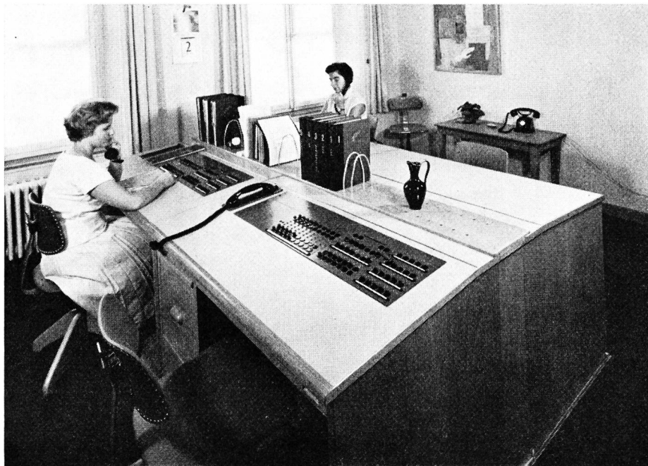
Fig. 8. Schnurlose Vermittlungsstelle in einer Nebenstellenzentrale Place de commutation sans cordon dans un central à installations secondaires
