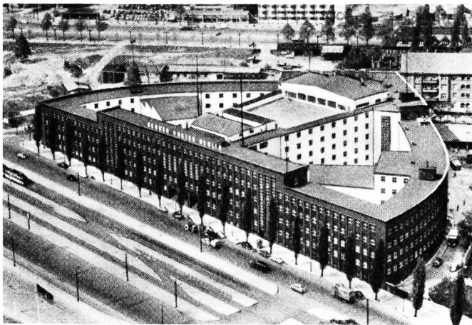
Fig. 2. Dem Funkturm gegenüber befindet sich das 1929 erbaute «Haus des Rundfunks», der heutige Sitz des «Sender Freies Berlin». Während in den nach aussen gelegenen Teilen des herzförmigen Gebäudes in erster Linie Büroräumlichkeiten untergebracht sind, befinden sich die Studios auf der Innenseite und den eigentlichen Innentrakten. Der mittlere und grösste von ihnen beherbergt das 15 000 m 3 grosse Musikstudio
