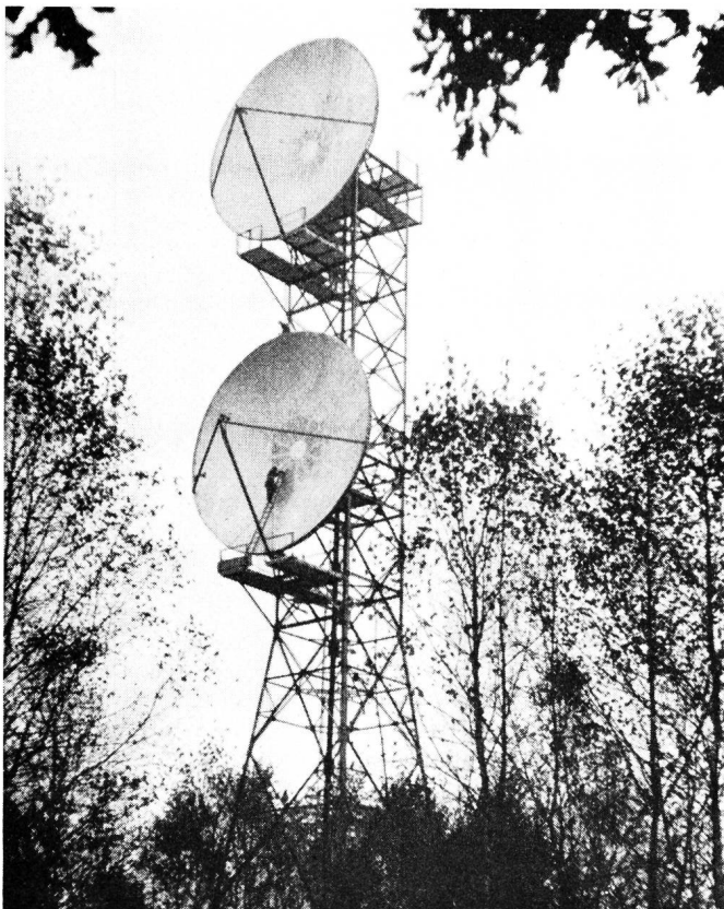
Fig. 10. Antennenanlage der Überreichweiten-Richtfunkanlage auf dem Schäferberg im Südosten Berlins. Die beiden Parabolspiegel haben je zehn Meter Durchmesser, die drei Streben tragen den Strahler im Brennpunkt des Spiegels
