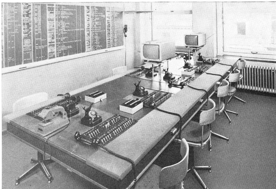
Fig. 4. Telephonzimmer einer Grossbank im Zürcher Börsengebäude, das jetzt mit Monitoren ausgestattet ist
