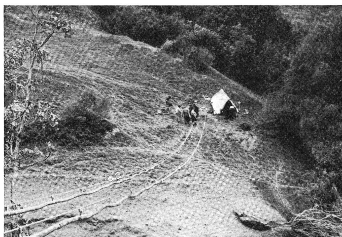
Fig. 3. Câbles provisoires, installation terminée
