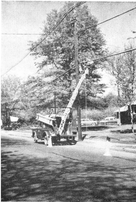
Fig. 4 Linien/Installations- monteur bei der Arbeit an einer Stange
