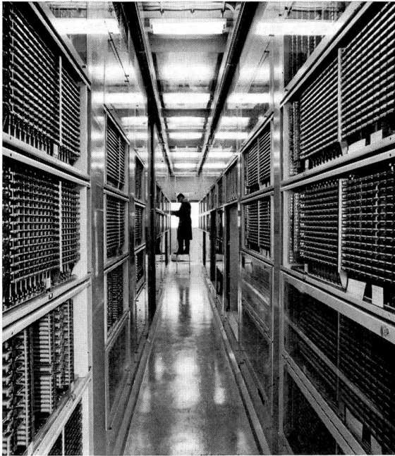
Pentacontaschalter-Rahmen für die automatische Anrufverteilung
