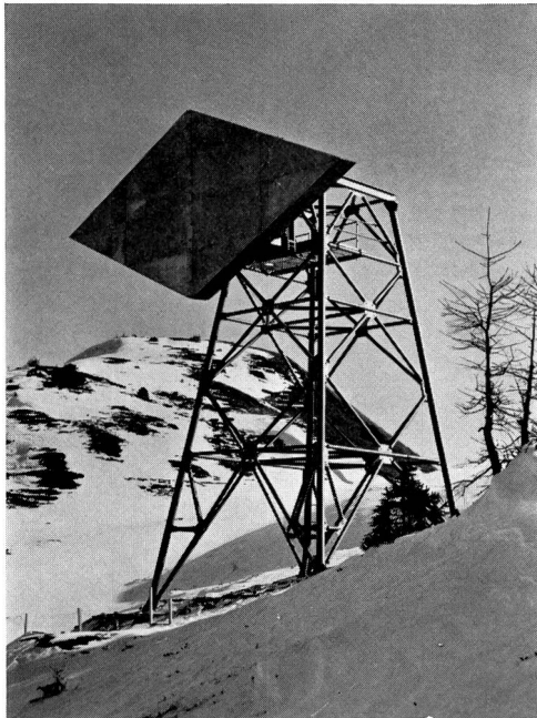
Fig. 1 Umlenkantennenanlage Ebne Matte im Oberwallis Relais passif de l'Ebne Matte dans le Haut-Valais
