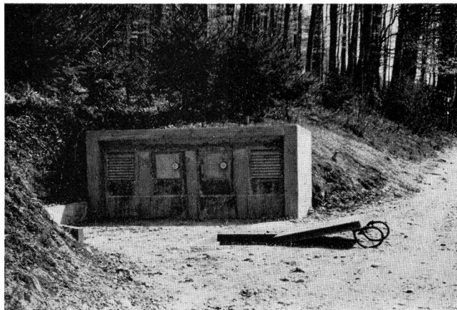
Fig. 24 Schachtaufbau bei zwei Verstärkern im gleichen Schacht
