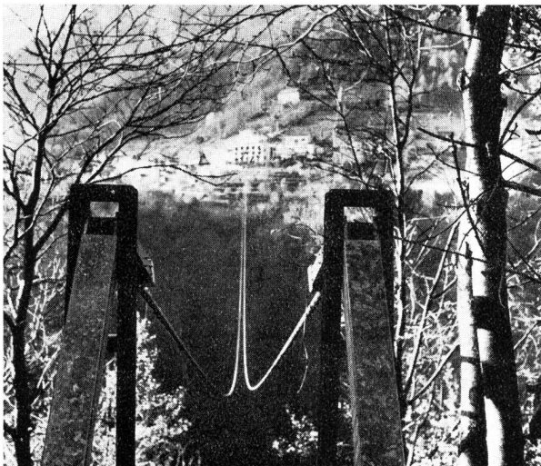
Fig. 1 Cavi autoportanti Auressio-Loce
