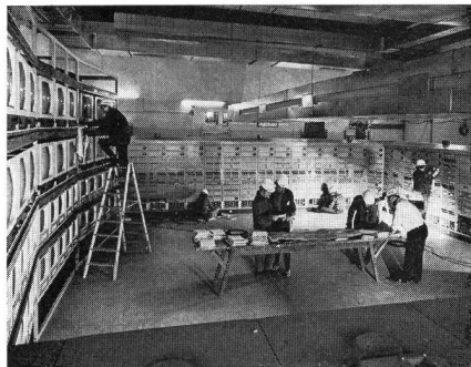
Fig. 1 Die im Bau befindliche TV-Schaltzentrale. Links die 48 Monitore, hinten und rechts ein Teil der insgesamt 61 Tongestelle
