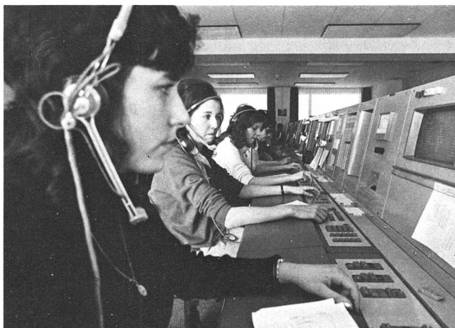
Fig. 8 Abfragedienst im Erstausbau mit 20 Plätzen, im Endausbau werden es 36 sein
