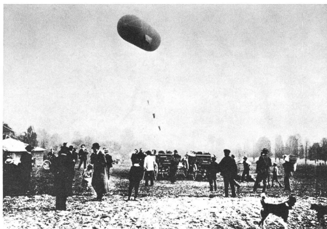
Fig. 1 Funkversuche der Armee im Jahre 1905 auf der Thuner Allmend; der Fesselballon dient als «Antennenträger» Essais de radiotélégraphie de l'armée en 1905 sur l'Allmend à Thoune. Le ballon captif sert de «support d'antenne»
