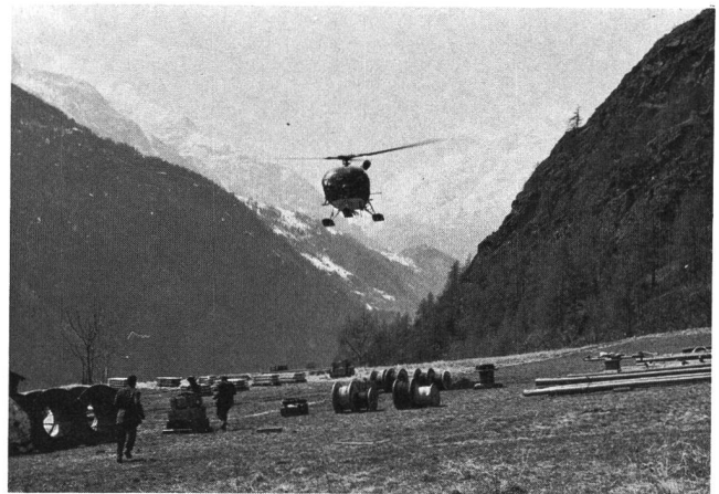
Fig. 4 Transport von Linienmaterial – Transport de matériel de ligne
