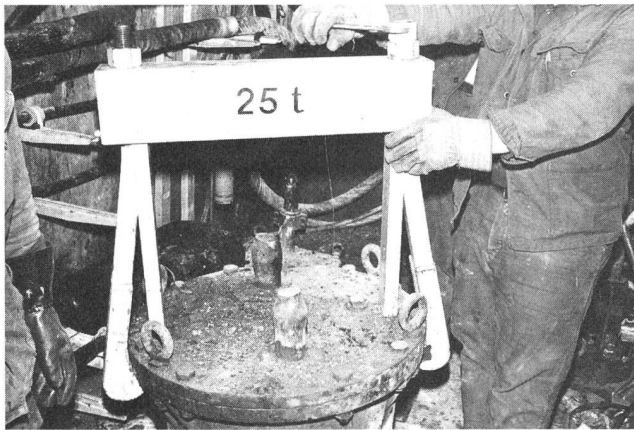
Fig. 3 Demontage der alten Pupintöpfe: Montage des Jochs und der Halteklauen – Démontage des anciens caissons Pupin: Mise en place du portique avec grappin
