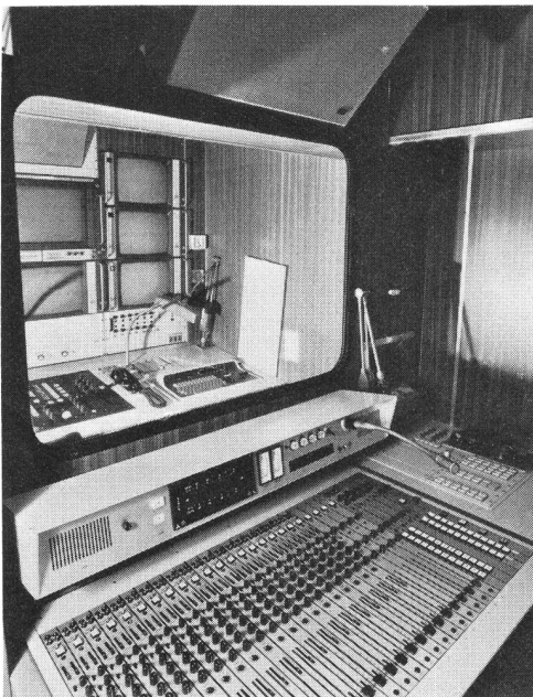
Fig. 8 Tonmischpult im Tonregieraum mit Sicht durch das Fenster in den Bildregieraum – Pupitre de mélange son dans le local de la régie son, avec vue sur la régie vidéo
