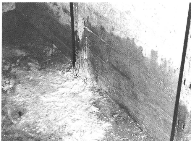
Fig. 7 Rohrblockanlage Egnach — Installation en tubes de matière synthétique d'Egnach
