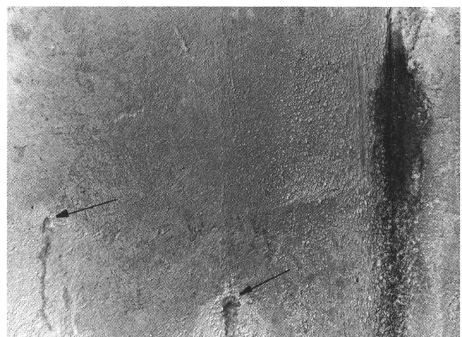
Fig. 8 Rohrblockanlage Egnach — Installation en tubes de matière synthétique d'Egnach
