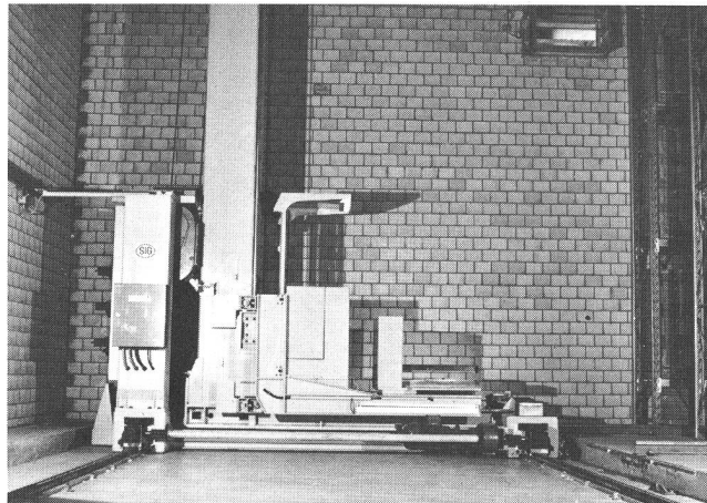
Fig. 13 Querversetzgerät mit Regalstapler
