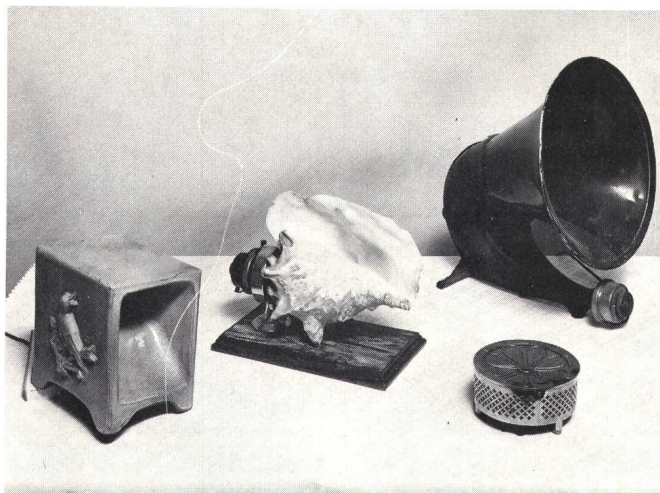
Fig. 7 Akustische Verstärker als Lautsprecher — Haut-parleurs selon le principe des amplificateurs acoustiques
